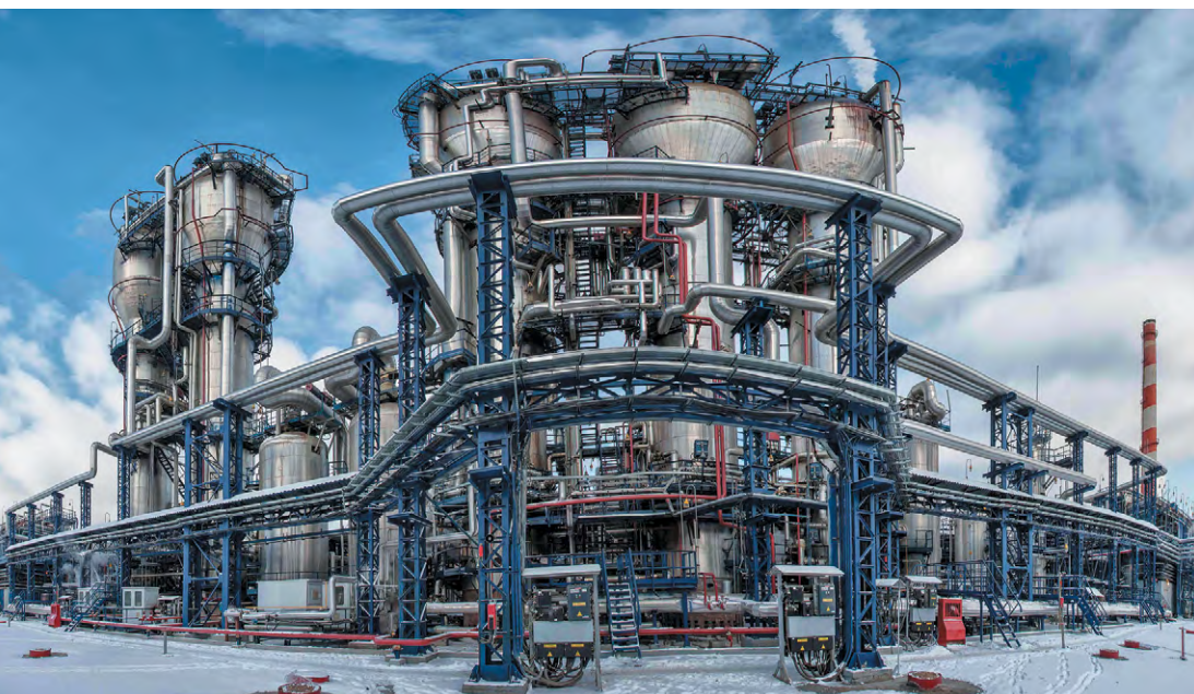
Первая в РФ установка каталитической депарафинизации дизельного топлива пущена в эксплуатацию на Омском НПЗ в 2012 году
